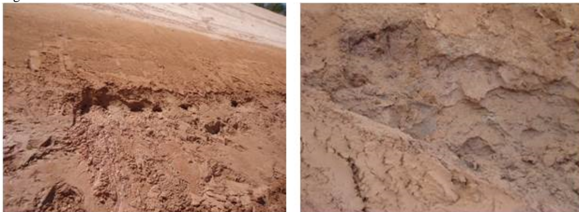
Figura 1. Erosão instalada na face do talude
